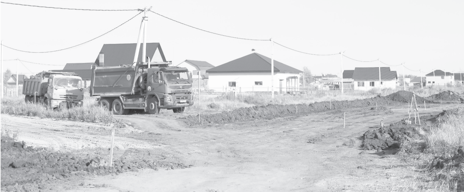
Для строительства щебёночных дорог зима не помеха, поэтому работы будут идти и в холодное время года /ФОТО АЛЕКСАНДРА СМЕРНОВА
