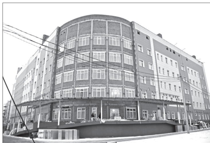
Строительство стационара ведется по графику и близится к завершению
