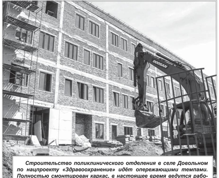
Строительство поликлинического отделения в селе Довольном по нацпроекту «Здравоохранение» идёт опережающими темпами. Полностью смонтирован каркас, в настоящее время ведутся работы по устройству мягкой кровли, утеплению фасада здания. Сдача объекта запланирована на декабрь этого года.
